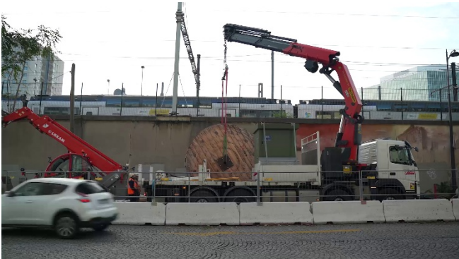
Fig. 5. Livraison du câble à Montparnasse-Vouillé.
