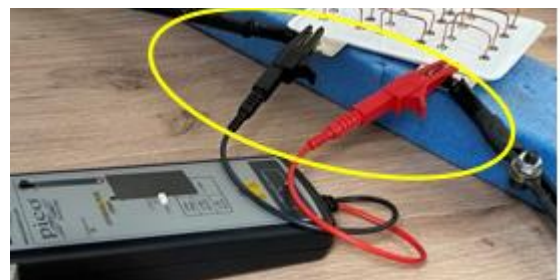
Fig. 14. Câbles d'alimentation pour alimenter le bus bar + les cosses du capteur de tension
