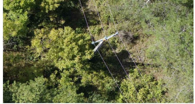
Fig. 4. Exemple de photo d'une ligne basse tension prise par Solaire X One
